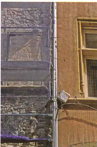
Mise à jour d'une baie moellonnée.
