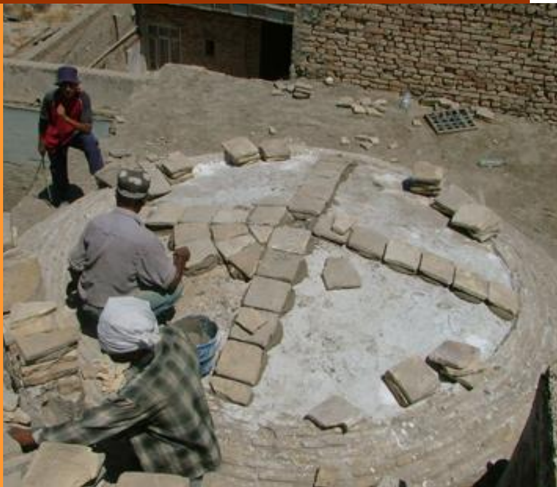
restauration de l'extrados de la coupole de la mosquée.
