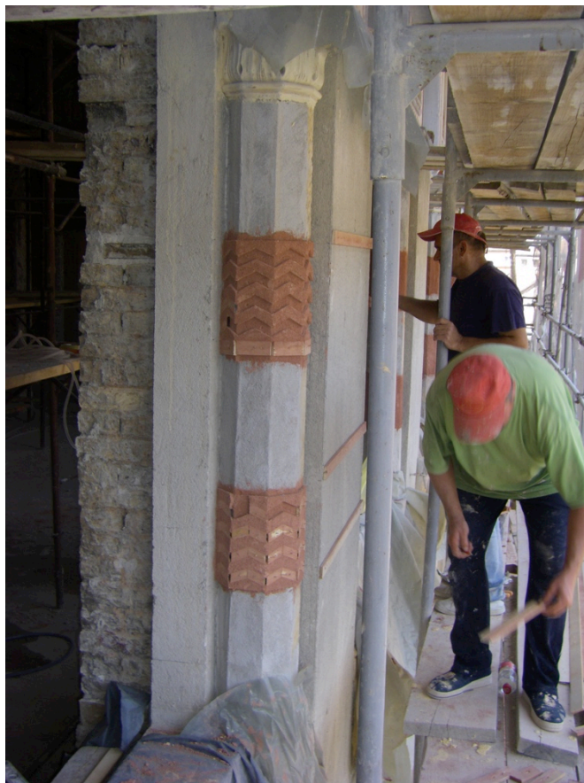
4. En 2012, restauration « à l'identique » des façades, des stucs, d'enduits et de mortiers colorés, de pierre de taille
