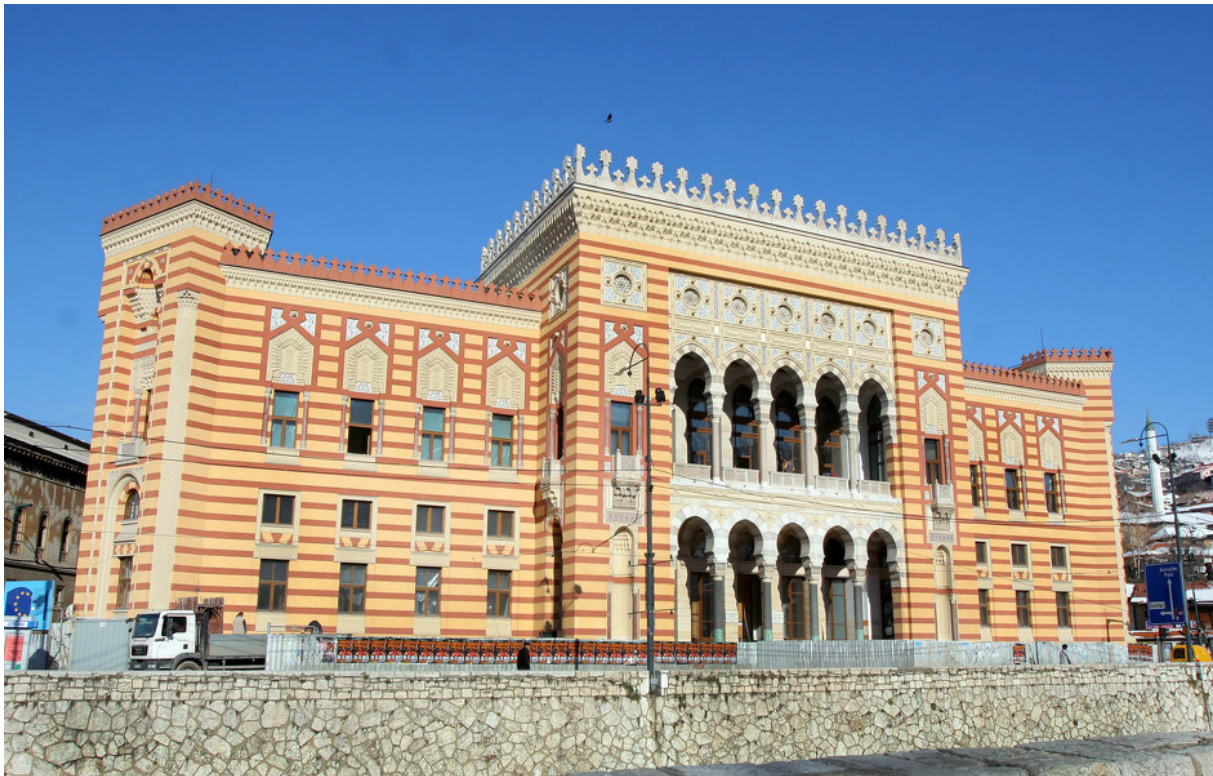
La façade principale sur la rivière au printemps 2014, la reconstruction est terminée (SU-2014).
