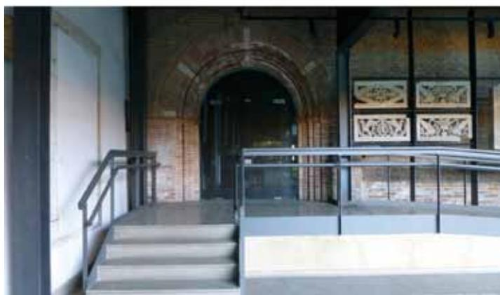
Fig. 9 – Deux images du cloître mineur réalisé en structure métallique selon le projet de Franco Albini de 1969-1970 ; l'accroche du cloître avec l'église a été modifiée au début des années 2000. En haut, la façade Sud du cloître ; en bas, détail d'une porte d'accès à l'église © cliché de l'auteur.
